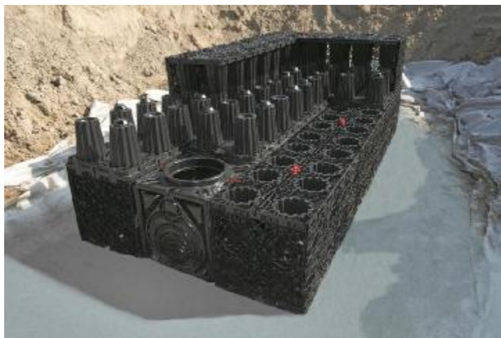
Primjer Stormbrixx sustava u izgradnji
